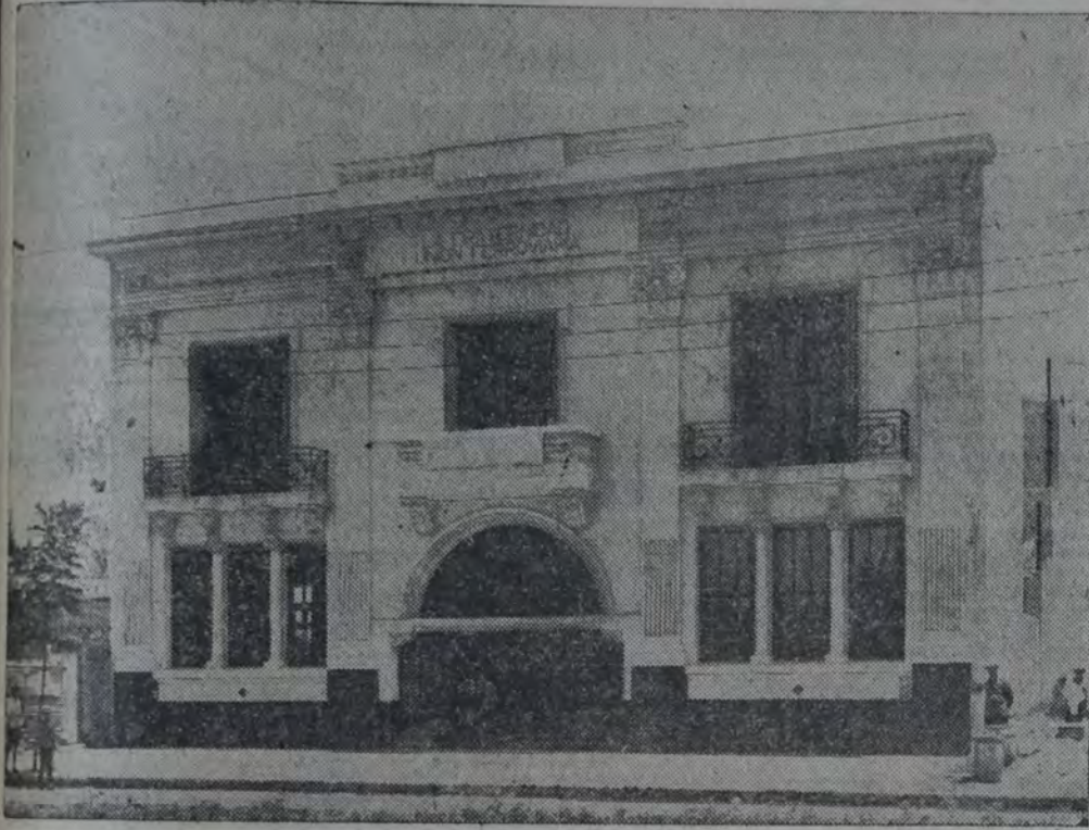
FRONTE DEL NUEVO EDIFICIO PROPIO DE AMBAS SECCIONES FERROVIARIAS DE REMEDIOS DE ESCALADA, situado en las calles Pavón entre Arrascaete y Pedro Salas.
